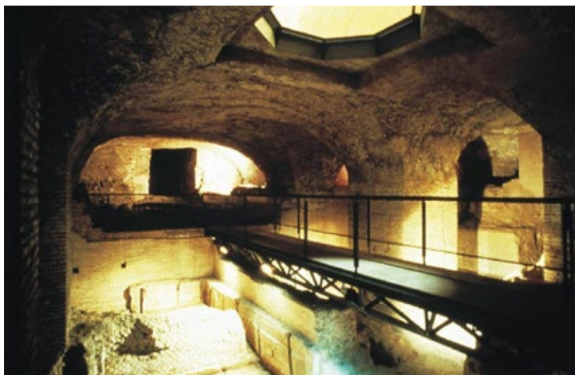
Fig. 4 Il livello inferiore dell'aula con l'occhio vetrato e la passerella di percorrenza del pubblico che contiene gli impianti (riscaldamento, illuminazione allarme).
