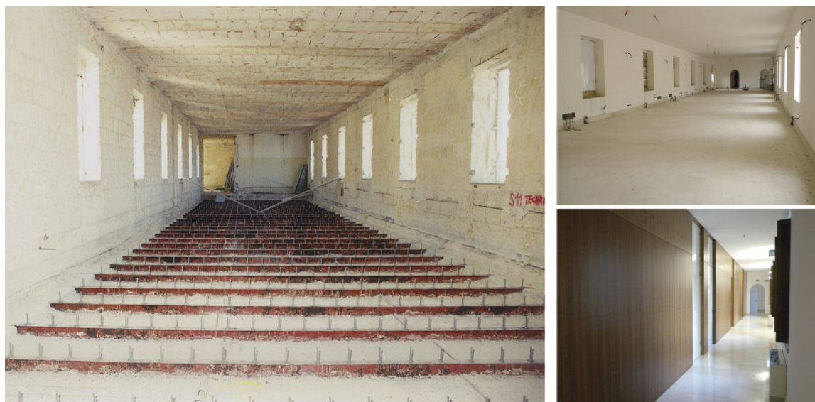
Fig. 9 Interventi strutturali (calpestio terzo piano) e sistemazione uffici.
