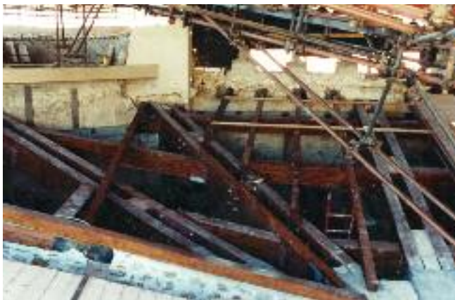
Fig. 17 Mezze capriate metalliche e muratura di quinta di controventamento - coperture mastio.
