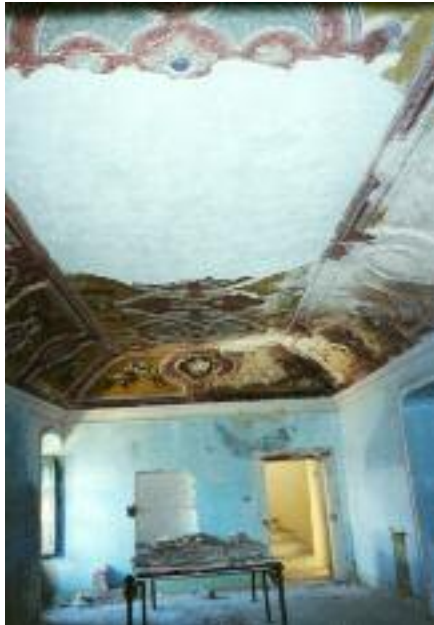
Fig. 23 Volta dell'incannicciata prima dei lavori.
