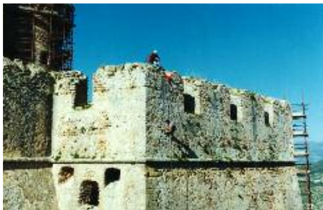
Da sinistra: Fig. 18 Opere di stabilizzazione del bastione dell'ospedale con l'impiego di rocciatori specialisti.
