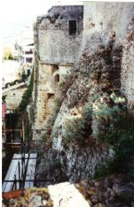
Fig. 14 Interventi nelle cavità rupestri della parete Sud-Ovest.
