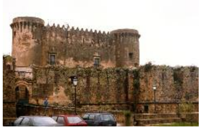
Fig. 7 Piazza Campo - Veduta della cortina dei doccioni prima del restauro.
