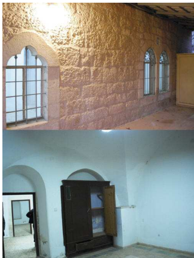
Fig. 5a e 5b Abitazioni da ristrutturare.
