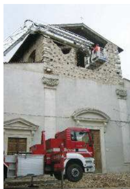
Fig. 12 Sopralluoghi congiunti in sito.
