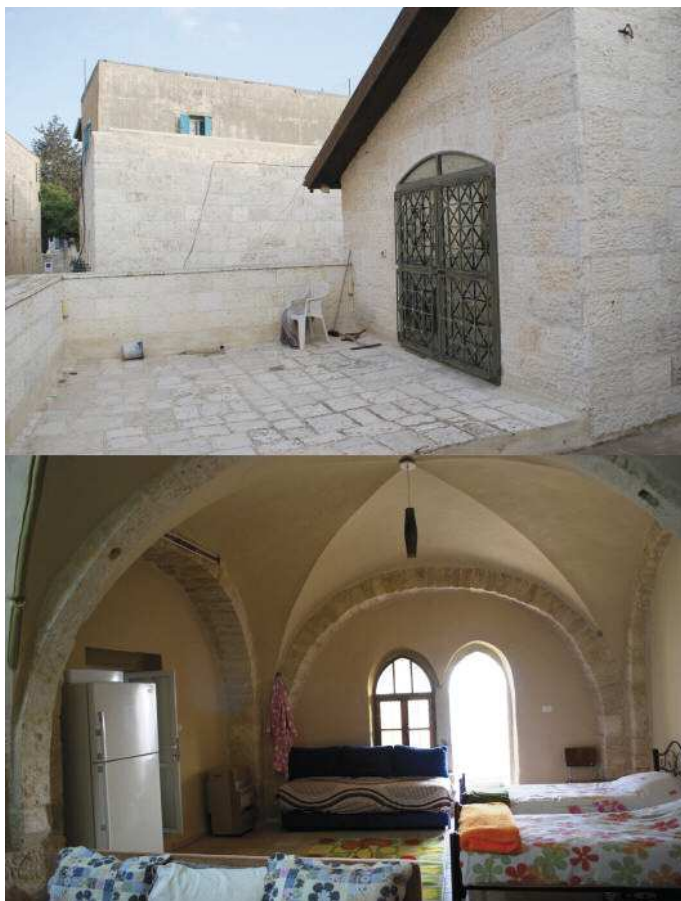
Fig. 6a e 6b Abitazioni da ristrutturare.
