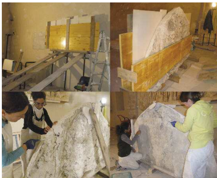
Fig. 14 Operazioni di smontaggio, casseratura e consolidamento dei calchi a parete.
