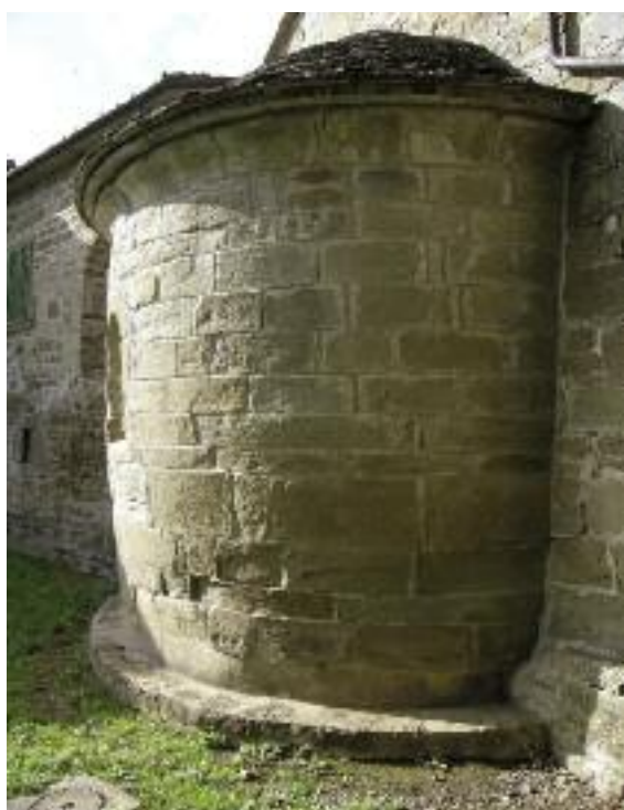
Fig. 4 Abside semicircolare costruita con blocchi di pietra irregolari, Caroni San Cristoforo, frazione di Caprese Michelangelo (AR).
