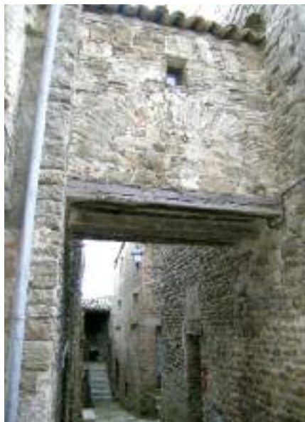
Fig. 9 Corpo di contrasto edificato, Monterone, frazione di Sestino (AR).
