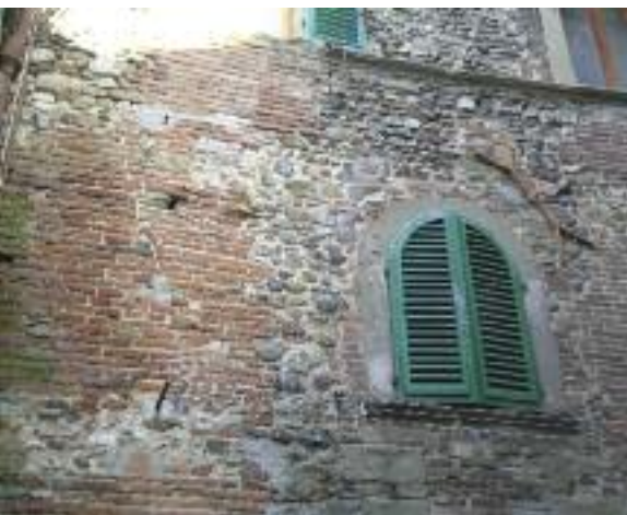
Fig. 7 “Aperture centinate definite da mostre di pietra sagomata e cornici davanzale continue”, Anghiari (AR).
