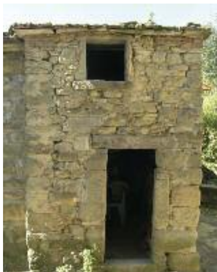
Fig. 2 Crepe nel sodo murario, Ca' di Corsino, frazione di Caprese Michelangelo (AR).
