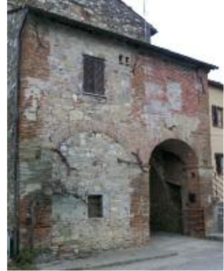
Fig. 1 Muratura disomogenea, Gagnano, frazione di Sansepolcro (AR).
