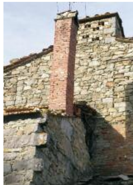
Fig. 10 Comignolo soggetto a caduta libera in caso di terremoto, Ca' del Tasso, frazione di Caprese Michelangelo (AR).
