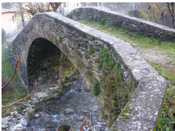
40 Equi Terme (Alpi Apuane): ponte di mulattiera sul torrente Fagli. L'intradosso dell'arco supera il livello del piano di campagna.
