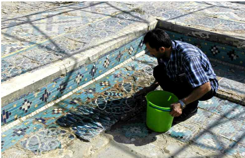
Fig. 7 Shahrisabz (Ouzbékistan), Un des bassins de l'Ak Saray, dégradé par des conditions météorologiques extrêmes durant l'hiver 2007-2008 (ici Dr Babur Aminov, Tachkent; ph: M. Schvoerer, 2008).
