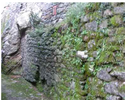
Muro di sostegno secolare che si aggancia direttamente alla roccia del monte.
