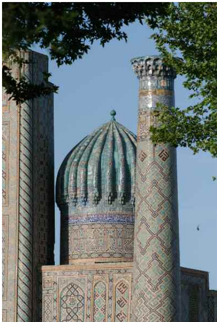
Fig. 4 Samarcande, Ouzbékistan. Détail des parties supérieures de l'une des madrasas du Registan (XVII ème s. ap. J.-C.). Les bâtiments sont entièrement recouverts de carreaux de céramique glaçurée avec une dominante bleu turquoise (ph: Schvoerer, 2008).
