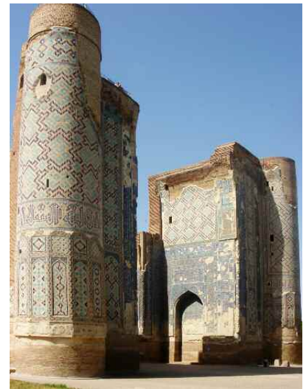
Fig. 5 Shahrissabz, Ouzbékistan. Façade Nord des pylônes d'entrée de l'Ak Saray (h: 44 m), recouverts de carreaux de céramique glaçurée (ph: Ollagnier, 2008).
