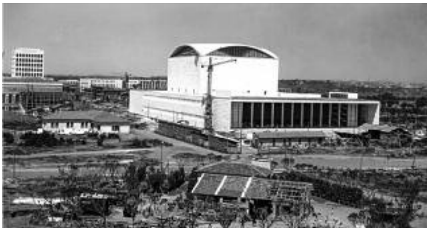
Fig. 7. E42, veduta del cantiere.
