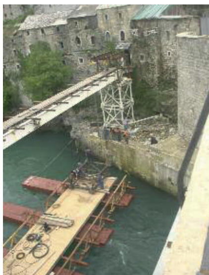
Reconstruction du pont de Mostar.
