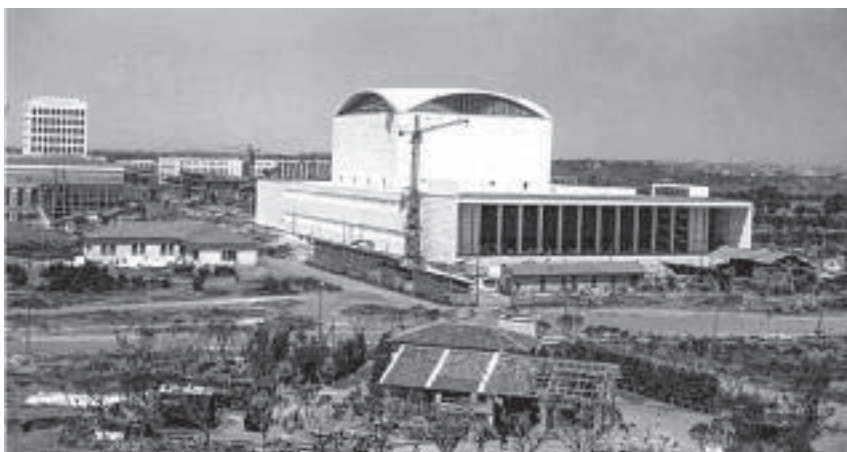
Fig. 7. E42, veduta del cantiere.
