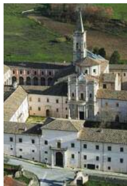
Fig. 30. Il corpo centrale della Badia Celestiniana dell'Annunziata di Sulmona.
