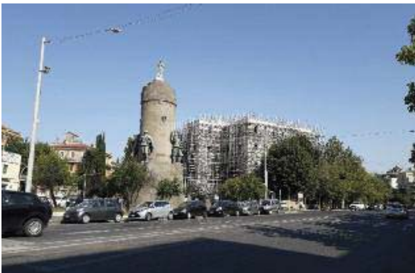
Fig. 22 Roma, Villa Paolina di Mallinckrodt, stato attuale (3 agosto 2020).
