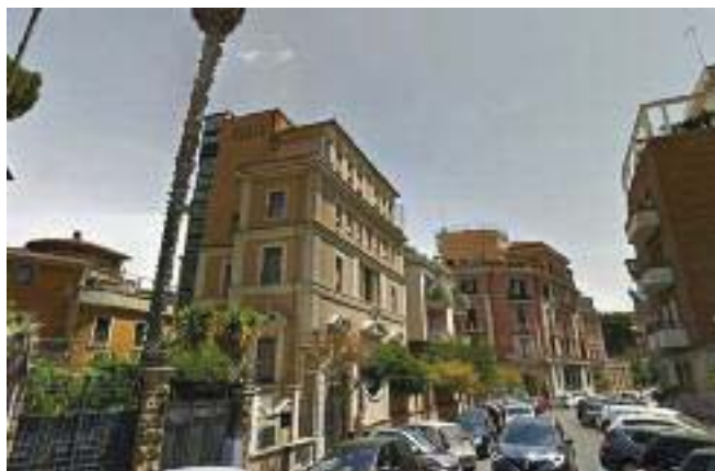
Fig. 18 Roma, via Ticino 3. Villino Naselli (1930), prima degli interventi di demolizione.
