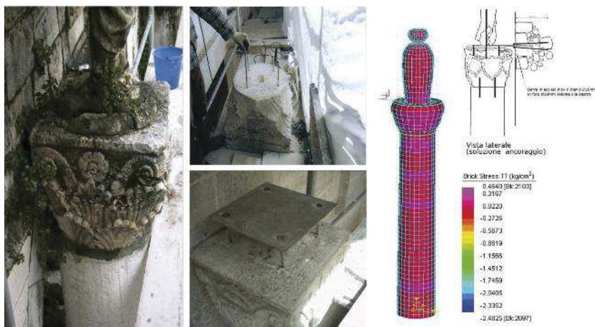
Fig. 5 Opera di restauro statico della colonna ed ancoraggio della statua di San Pietro.
