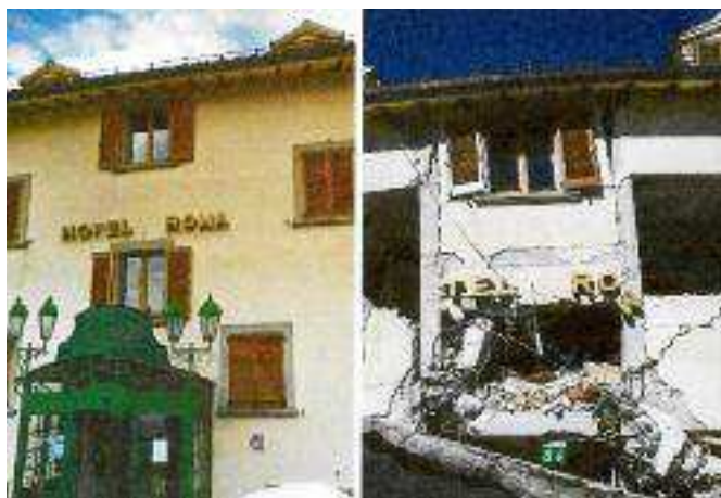
Fig. 1 Amatrice, Hotel Roma prima e dopo l'evento sismico. L'aspetto esterno tradizionale nascondeva un robusto telaio in armatura di cemento. Vi furono vittime.
