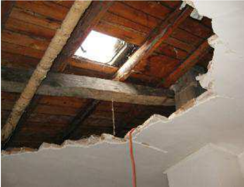
Fig. 6 Crollo di un soffitto di mattoni in foglio. L'esame immediato della meccanica del danno e la sua rubricazione sono strumenti idonei per rimuovere o ridurre le situazioni di rischio in previsione di eventi successivi.
