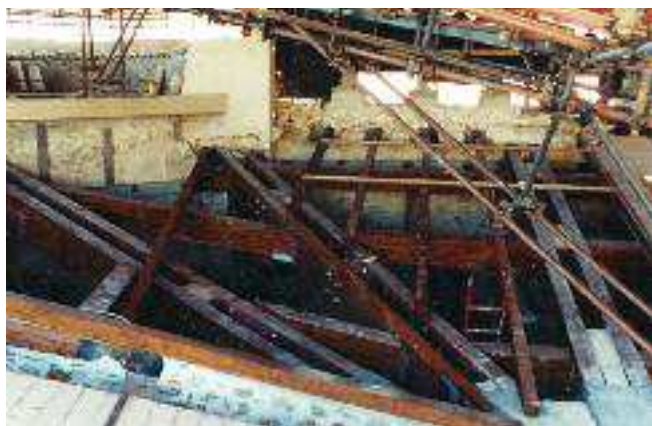
Fig. 17 Mezze capriate metalliche e muratura di quinta di controventamento - coperture mastio.
