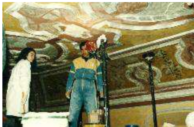
Fig. 24 Assemblaggio dei frammenti della volta della sala da pranzo.
