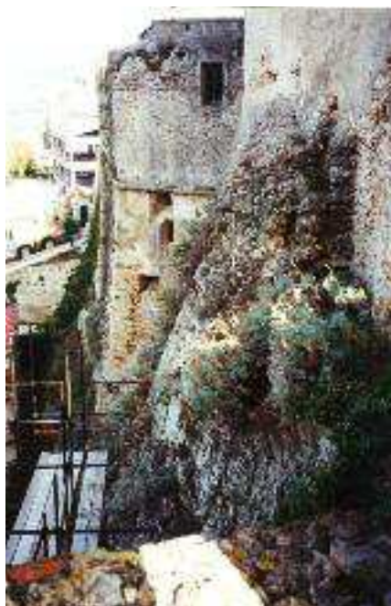
Fig. 14 Interventi nelle cavità rupestri della parete Sud-Ovest.
