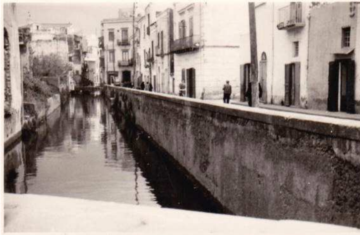
Fig. 1 Via Zara, Scafati.
