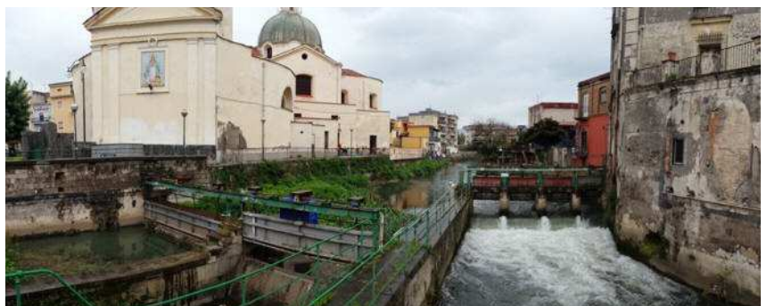
Fig. 2 Traversa di Scafati.
