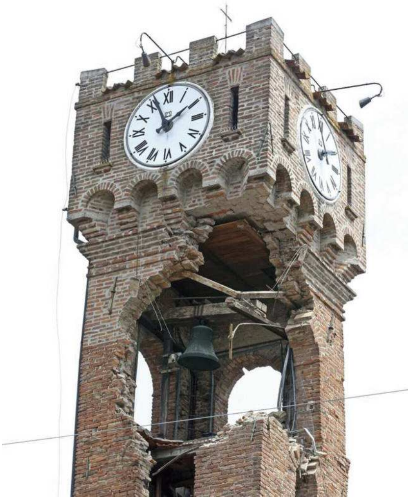
L'antica torre dell'orologio di Novi di Modena, 2012
