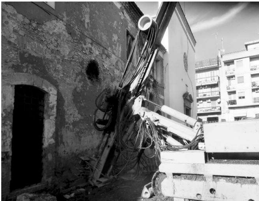
Fig. 9 Sondaggio subverticale in aderenza al muro della facciata principale.
