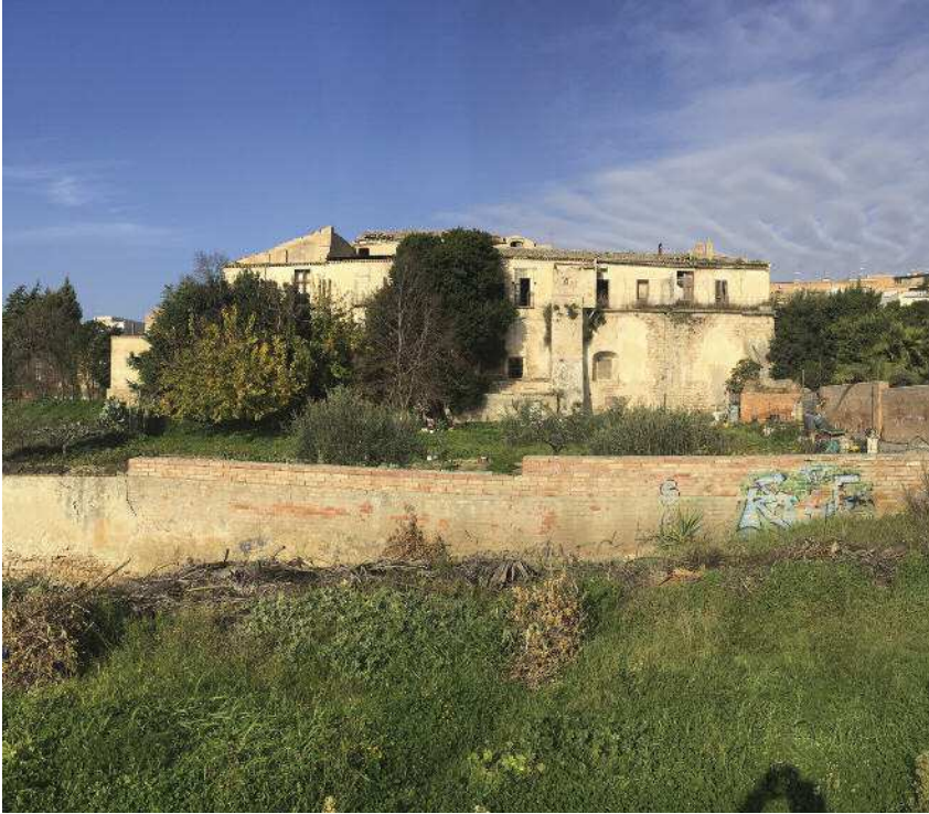
Fig. 1 Facciata laterale di sud-est: dissesti nelle coperture e vegetazione infestante.
