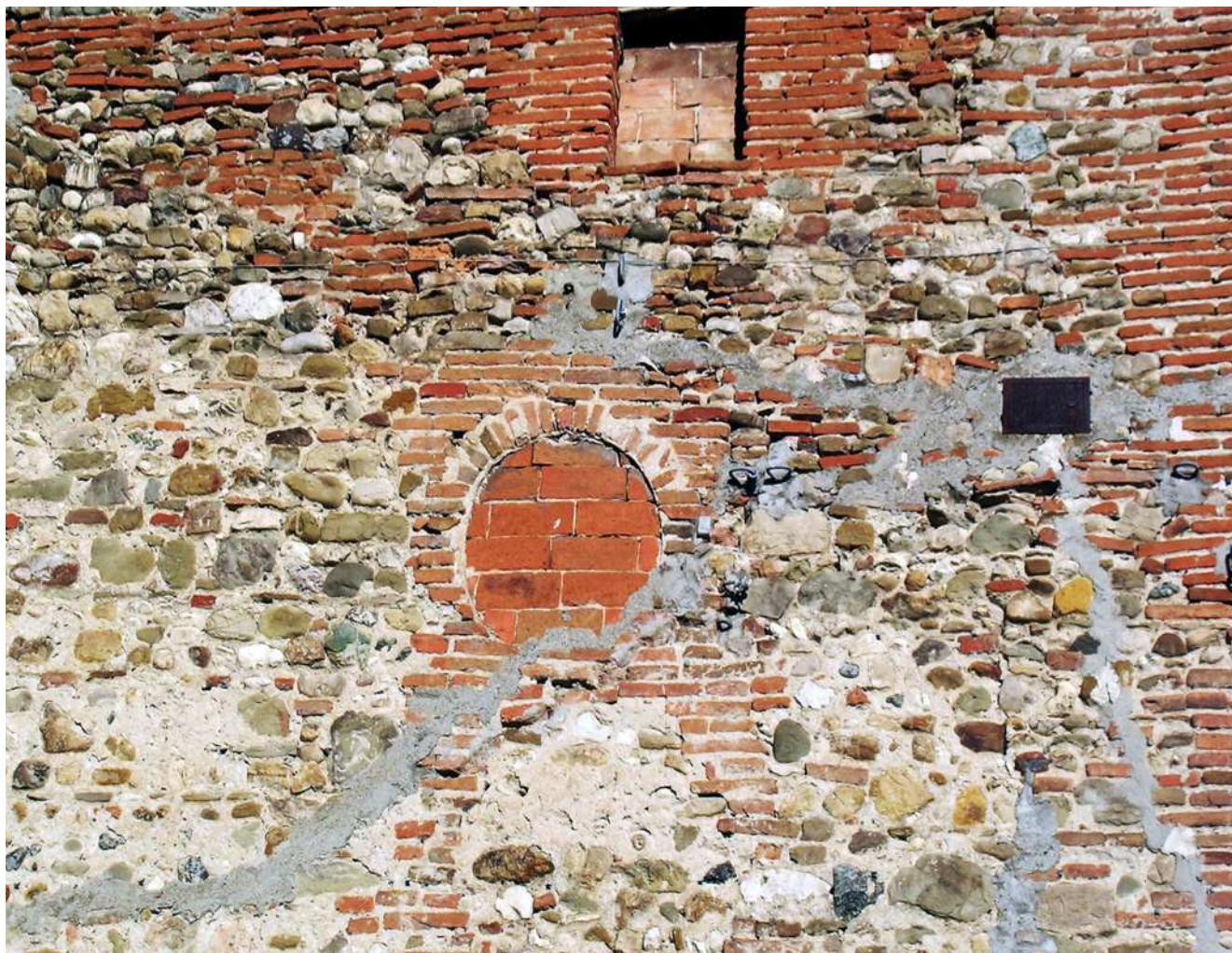
Fig. 15 Muratura disomogenea, Anghiari (AR).
