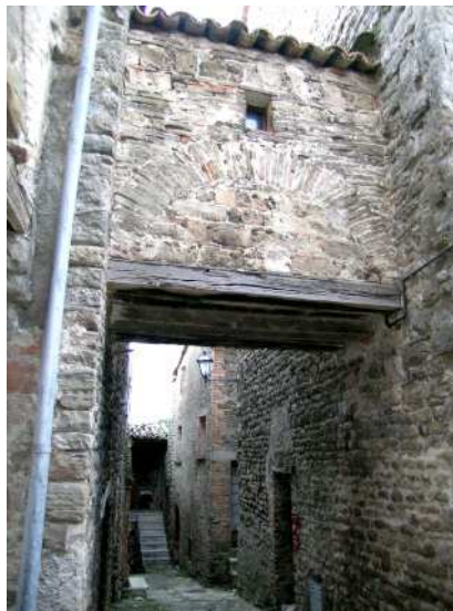
Fig. 13 (a sinistra) Corpi di contrasto, Monterchi (AR).
