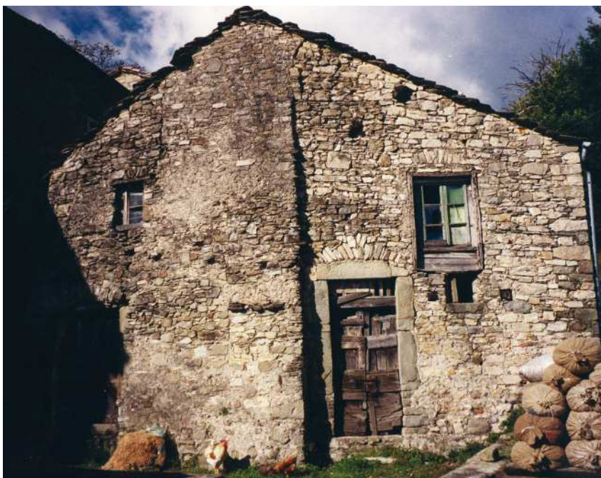
Fig. 8 Rinforzo murario in una casa della frazione di Apella (Licciana Nardi MS).
