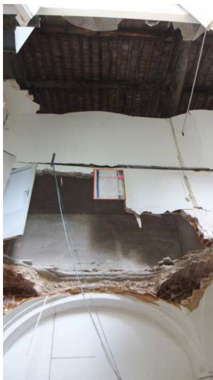
Fig. 3 L'Aquila, Conservatorio di Collemaggio.
