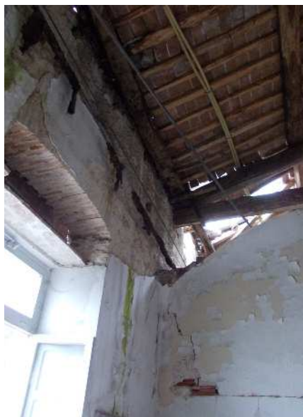
Fig. 5 L'Aquila, Conservatorio di Collemaggio.
