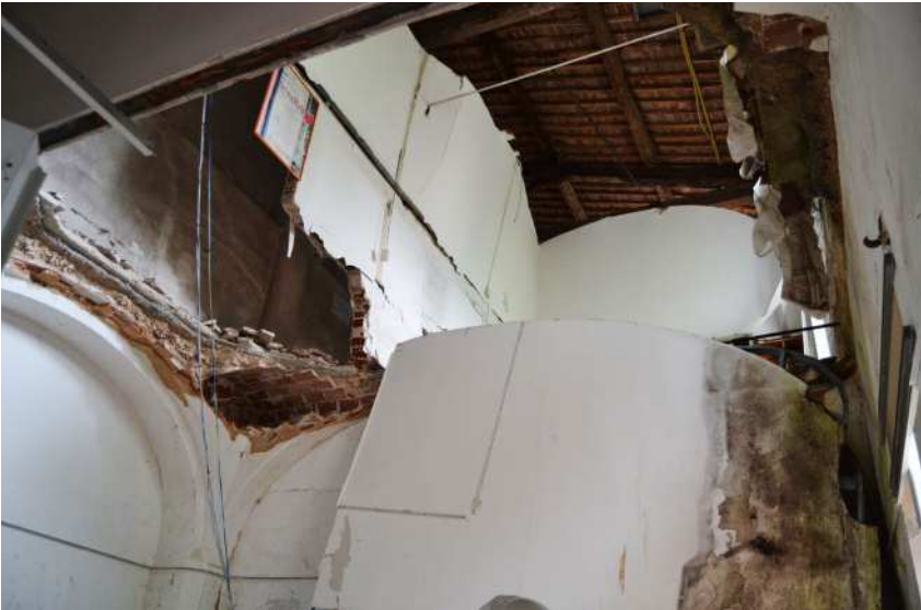
Fig. 4 L'Aquila, Conservatorio di Collemaggio.
