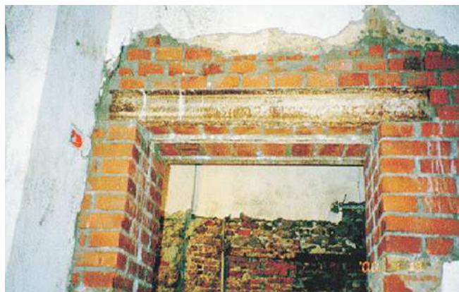
Fig. 12 Nel caso di architravi di porte o finestre, la riparazione e/o sostituzione sarà in funzione della tipologia costruttiva: piattabanda in putrelle o arco ribassato (1999).
