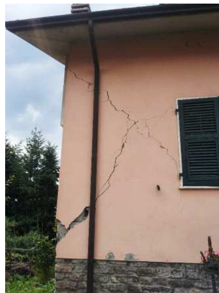
Fig. 27 Fivizzano, edificio costruito nel 1980 con criteri sismici e dichiarato inagibile.
