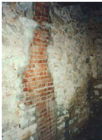
Fig. 16 Ricostruzione della muratura con mattoni e collegamenti con barre acciaio inghisate con malta cementizia (1999).
