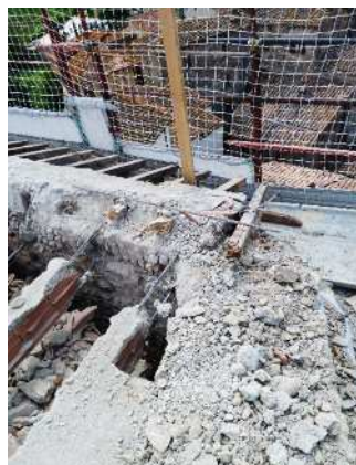
Fig. 17 Demolizioni di copertura in latero cemento (1999).
