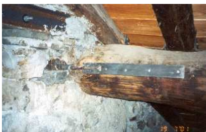
Fig. 14 Collegamento tra la muratura e l'orditura lignea di tetti e solai in legno mediante piastre sagomate in acciaio (1999).
