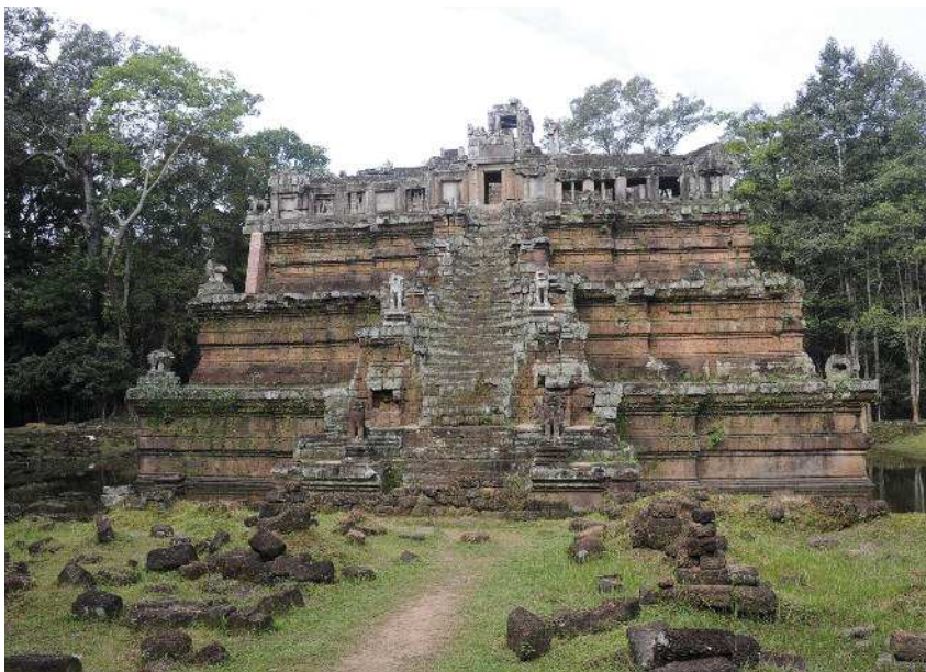
Fig. 5 Temple de Phimeanakas. L'essentiel du corps est constitué de grès rouges. Au premier plan, comme sur la bordure de la douve (à gauche et à droite de la photo), se trouvent des blocs de cuirasse ferralitique. Enfin, l'habillage de grès verdâtres a permis les sculptures ornementales (cliché J.-N. Salomon, 2014).
