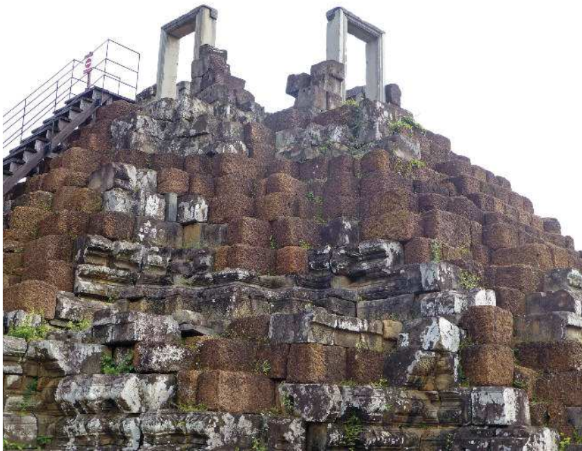
Fig. 4 Le temple de Baphuon à Angkor Thom : une grande partie des grès d' « habillage » (gris et blancs) a disparu laissant apparaître les blocs de cuirasse (rouges, à texture grumeleuse) constituant l'essentiel de la masse interne du temple (cliché J.-N. Salomon, 2014).
