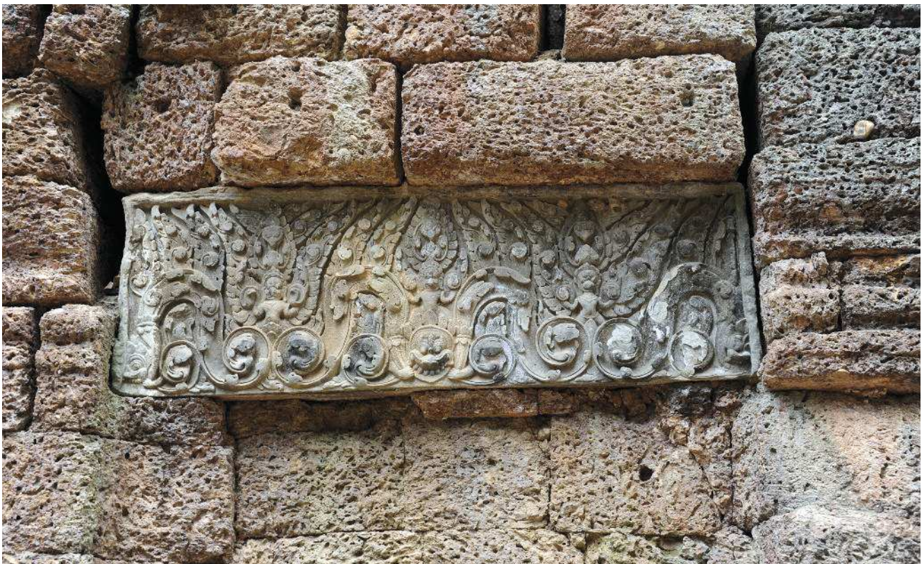
Fig. 7 Un exemple de l'utilisation du grès : un linteau du temple de Ta Prohm plus facile à travailler que la cuirasse vacuolaire qui l'entoure (cliché J.-N. Salomon, 2014).
