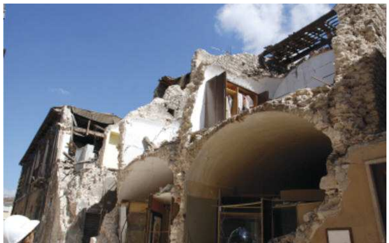
Fig. 2 All'Aquila le volte hanno resistito egregiamente (a), anche quando le spinte non sono contrastate (b).
