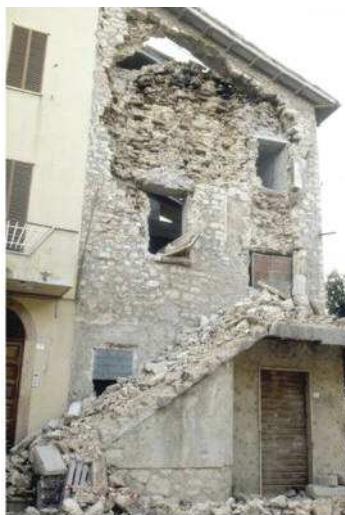
Fig. 3 I solai in legno accompagnano la deformazione delle strutture, quelli in c.a. non si deformano. Ne risultano spinte dall'interno verso l'esterno, che fanno saltare il paramento esterno delle murature storiche di questo edificio di Sellano (a sinistra).
