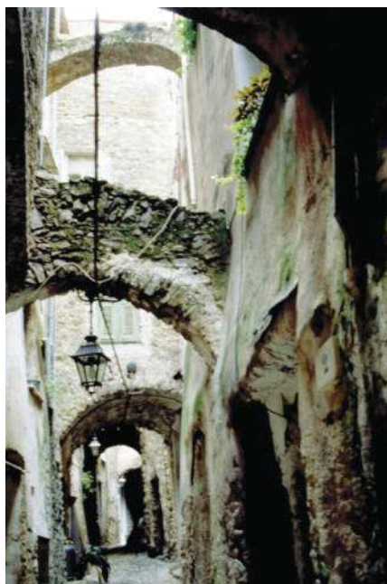
Fig. 5 Gli archi in primo piano hanno una evidente funzione statica. Ma il passaggio voltato in fondo è stato realizzato per stabilizzare le due facciate o per ampliare le abitazioni che si affacciavano sulla strada?
