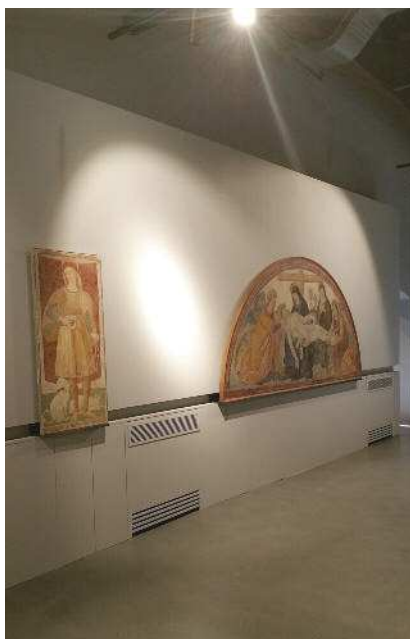
Fig. 24 Da notare la posizione delle griglie dei fan-coil sotto ai dipinti su tavola.
