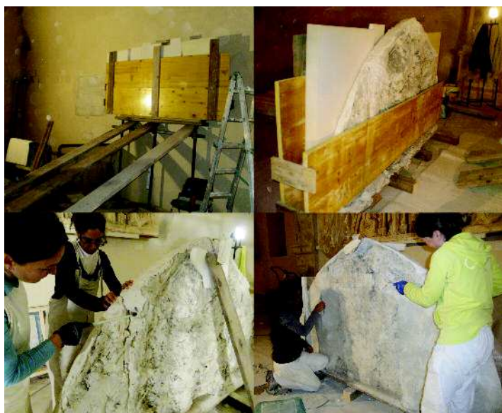
Fig. 14 Operazioni di smontaggio, cassera e consolidamento dei calchi a parete.
