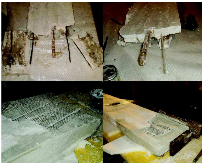
Fig. 11 Armature ammalorate e ossidate con espulsione di materiale; sostituzione delle armature ammalorate con tondini in vetroresina; rinforzo dell'armatura con l'aggiunta di una rete in fibra di vetro; stuccatura e integrazione plastica.
