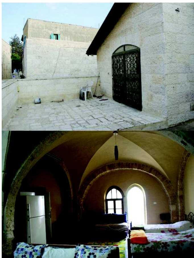
Fig. 6a e 6b Abitazioni da ristrutturare.
