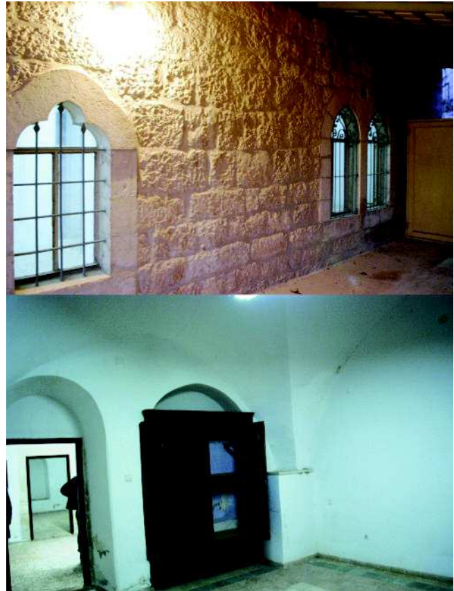
Fig. 5a e 5b Abitazioni da ristrutturare.
