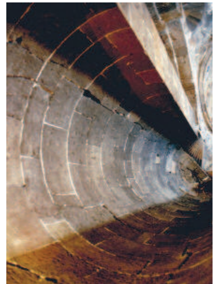
Fig. 9 Chiesa di S. Hripsimè, rinforzo semicilindrico interno.
