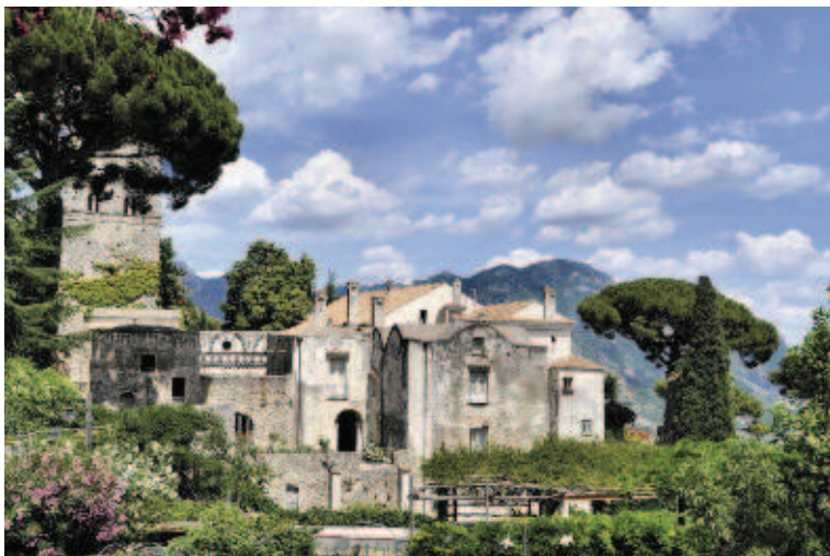
Fig. 1 Ravello, Villa Rufolo: veduta panoramica.
