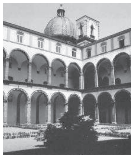
Napoli, complesso conventuale di S. Pietro martire, dopo i lavori di restauro.
