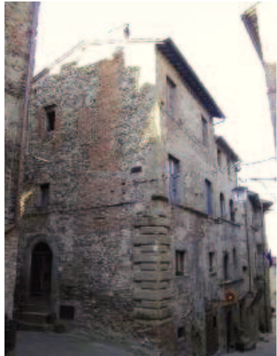
Fig. 3 Muratura disomogenea, ogni intervento di trasformazione nel sodo murario può compromettere l'omogeneità della muratura, Anghiari (AR).
