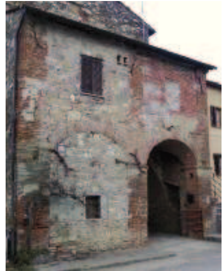
Fig. 1 Muratura disomogenea, Gagnano, frazione di Sansepolcro (AR).
