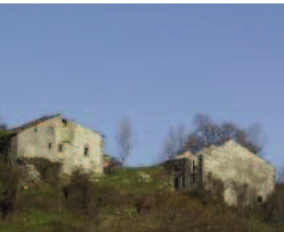
Fig. 6 Stato di abbandono e di degrado, Badia Tedalda (AR).
