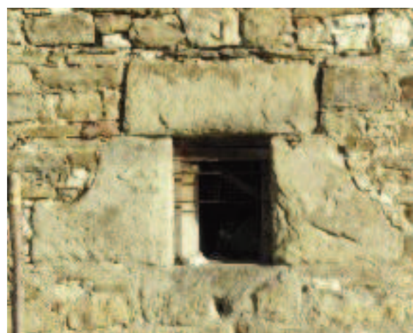
Fig. 8 Negli insediamenti di maggiore altitudine l'uso della pietra lavorata è pressoché esclusivo, Badia Tedalda (AR).
