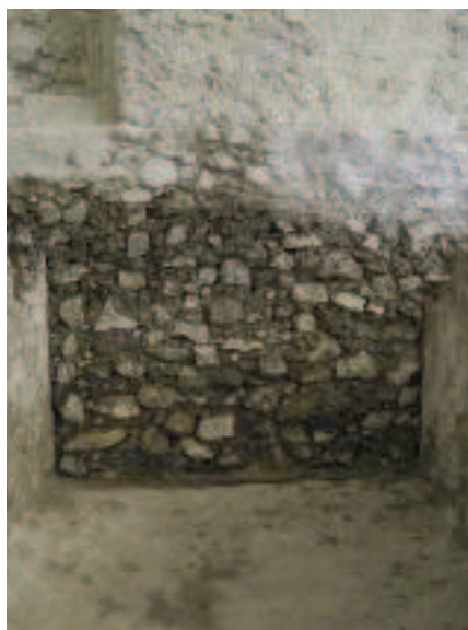
Figg. 10 e 11 Muro del chiostro innestato all'interno della cisterna.
