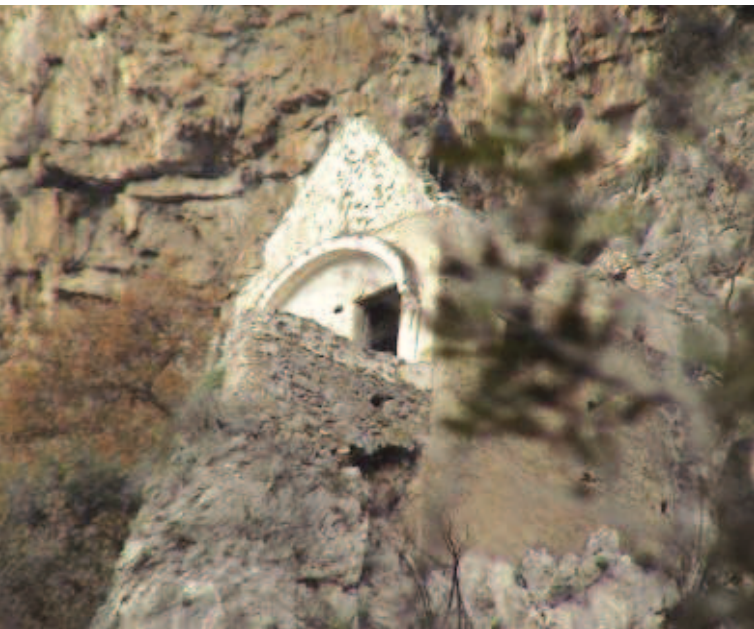
Casa lungo la strada per S. Lazzaro, Amalfi
