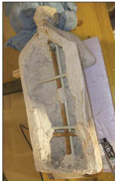
Fig. 16 Consolidamento e integrazione delle armature in bambù ammalorate con tondini in vetroresina.
