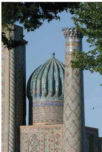
Fig. 4 Samarcande, Ouzbékistan. Détail des parties supérieures de l'une des madrasas du Registan (XVII ème s. ap. J.-C.). Les bâtiments sont entièrement recouverts de carreaux de céramique glaçurée avec une dominante bleu turquoise (ph: Schvoerer, 2008).
