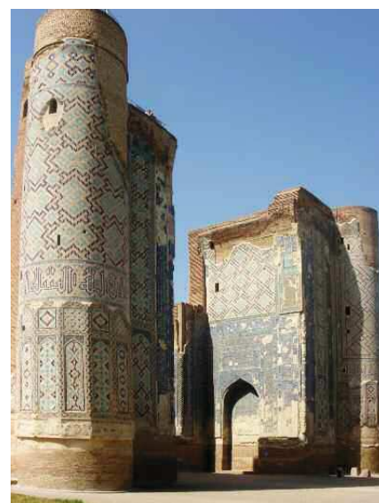
Fig. 5 Shahrissabz, Ouzbékistan. Façade Nord des pylônes d'entrée de l'Ak Saray (h: 44 m), recouverts de carreaux de céramique glaçurée (ph: Ollagnier, 2008).
