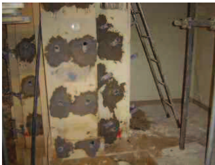
Fig. 3 Chiesa di Santa Caterina in località Santa Caterina a Scala. Realizzazione del rinforzo con iniezioni di malta nella pilastratura della suddetta chiesa (fonte Raffaello Gambardella)
