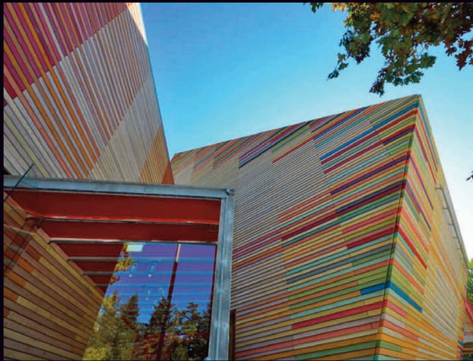
Renzo Piano, Auditorium del Parco, L'AQUILA
