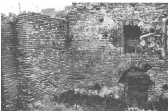
*Fig. 10. Ercolano. Terme Centrali : slittamento di muro.*
